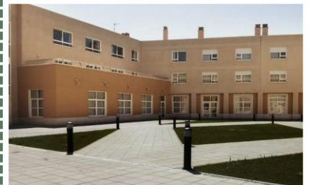
Clece Bañosalud – Venta de Baños, Palencia Adquisición: Julio 2019 Operador: Clece Mayores 188 plazas + 14 centro de día Renta: Fija
